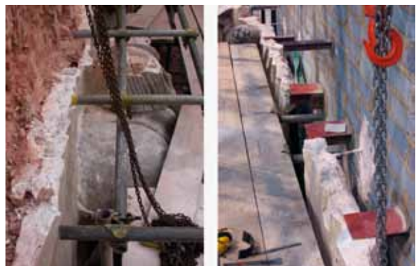
Links de installatie methode uit 1950, rechts de reversible installatiemethode van 2009
