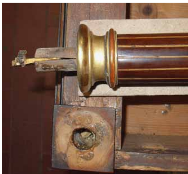
Assemblage à tourillon et coin de serrage
