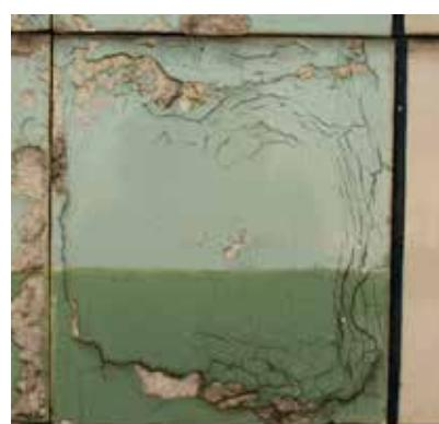
Fig. 13 : Altération localisée dans le pourtour d'un carreau / Verwering aan de randen van een tegel. (Photo/foto © G. Bussienne)
