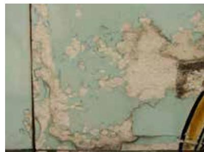
Fig. 14 : Détachement de cupules de matière dû au gel / Vorstschade in de vorm van afschilfering (Photo/foto © G. Bussienne)
