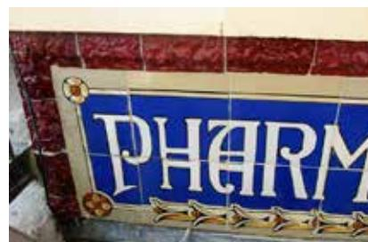
*Fig. 21 : Repose des reconstitutions et des carreaux déposés dans le mot « Pharmacie » / Plaatsen van de reconstructies en ontbrekende tegels in het woord « Pharmacie ». (Photo/foto © G. Bussienne)*
