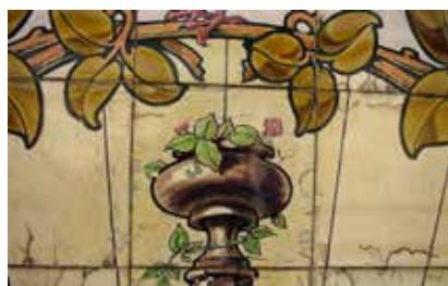
*Fig. 17 : Encrassement incrusté dans les fissures / Vuilafzetting in de barsten. (Photo/foto © G. Bussienne)*
