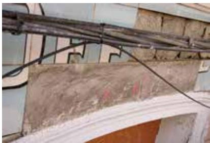
Fig. 10 : Carreaux manquants dans le mot « Defense » / Ontbrekende tegel in het woord « Defense ». (Photo/foto © G. Bussienne)
