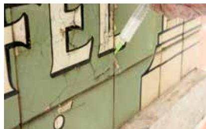
Fig. 19 : Refixage des écailles / Fixatie van de schilfers. (Photo/foto © G. Bussienne)
