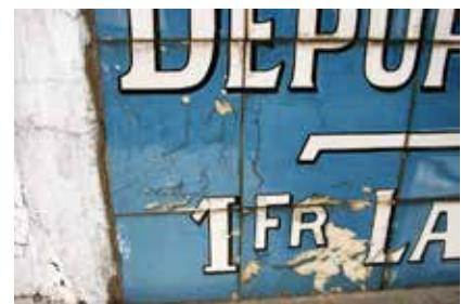
Fig. 12 : Fissures, pertes de matière et d'émail / Barsten en materiaalverlies. (Photo/foto © G. Bussienne)
