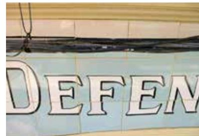
*Fig. 20 : Repose des reconstitutions et des carreaux déposés dans le mot « Defense » / Plaatsen van de reconstructies en ontbrekende tegels in het woord « Defense ». (Photo/foto © G. Bussienne)*
