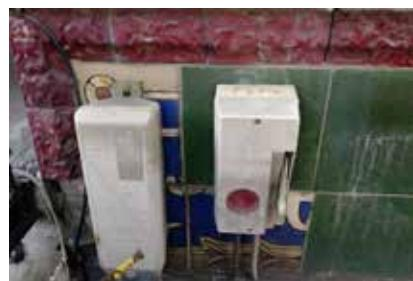
Fig. 11 : Carreaux unis ayant servi au remplacement de carreaux manquants / Effen tegels gebruikt als vervanging van de ontbrekende tegels. (Photo/foto © G. Bussienne)
