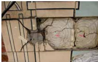
*Fig. 16 : Dégâts provoqués par la pose d'un ancrage métallique / Schade veroorzaakt door metalen verankering.
