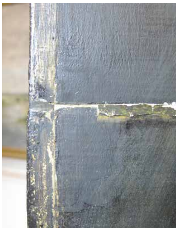
Fig. 8 : Dégagement de mastic plus ancien débordant sur la couche picturale originale – surpeints au niveau des bords latéraux à l'origine non peints/ vrijlegging van oudere mastic die de originele verflaag bedekt - overschilderingen ter hoogte van de laterale boorden die oorspronkelijk niet geschilderd waren (Photo/foto ©E. Job)
