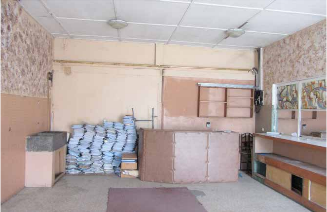
fig. 2: Local de C/R avant travaux de rénovation / Lokaal van C/R vóór de verbouwingswerken
