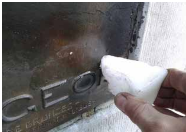
Fig. 11 : Application de la cire à chaud (Photo © Laurent Labat)
