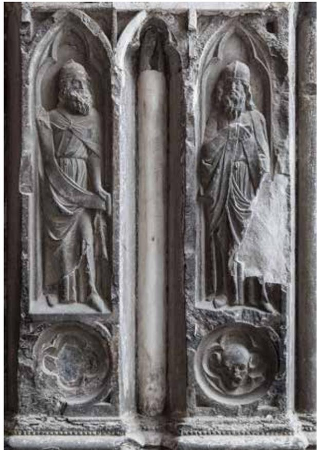
Fig. 5 Détail du registre inférieur en pierre de Tournai. Les pertes de matière sont provoquées par le délitage de la pierre. (X079087 © KIK-IRPA, Bruxelles, 2015)
