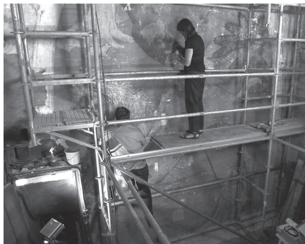
Zicht op de werkzaamheden in de Sint-Janskerk. Vue sur le chantier.
