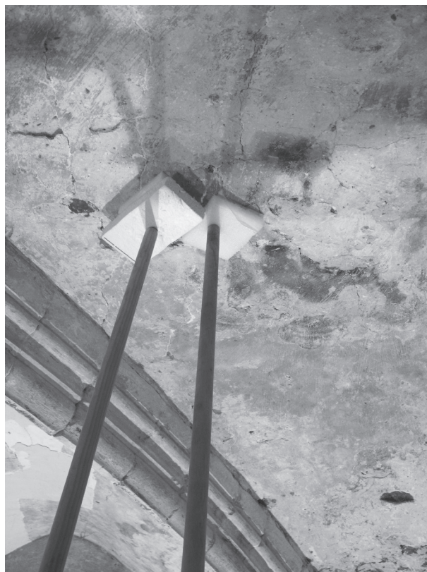
Stutten van de gefixeerde zone. Eتانچonnage des zones dans les voûtes après fixage.
